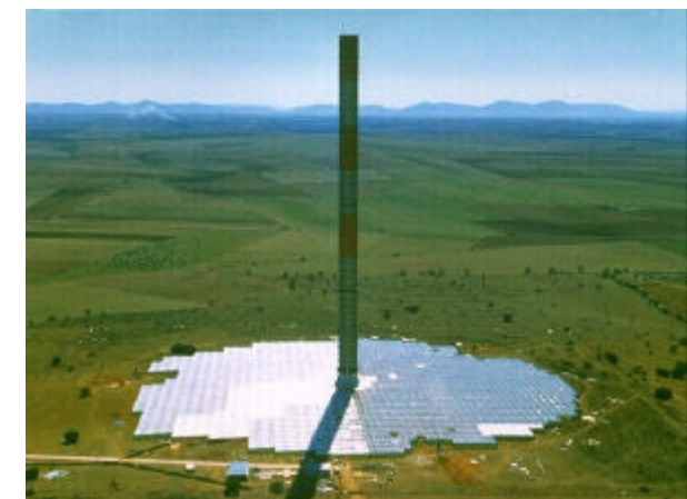
Bild 4: Prototyp für ein Aufwindkraftwerk in Manzanares, Spanien
